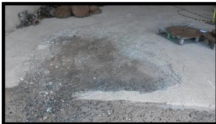
Figura 09 - Piso danificado dentro do Galpão de Teste Hidrostático (Acervo Pessoal).
