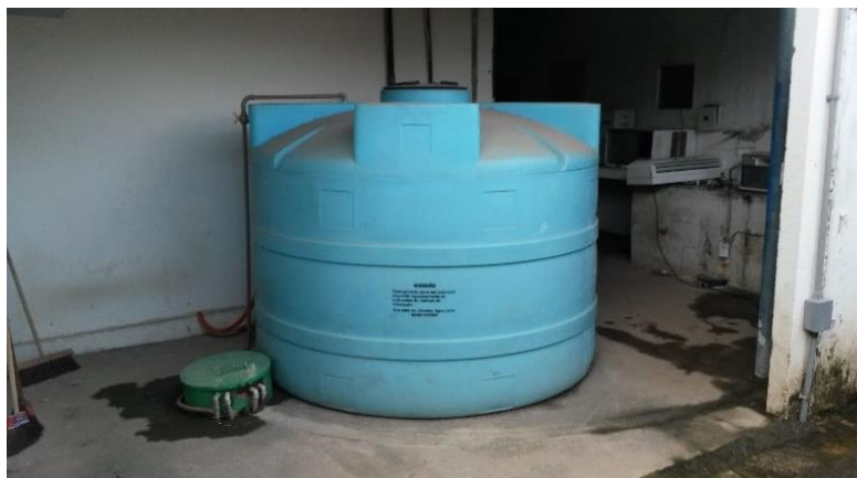
Figura 32 - Caixa d'água de 5 m³ próximo ao Vestiário. (Acervo Pessoal)
