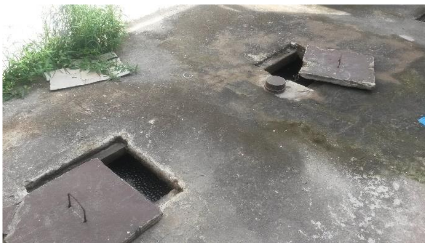
Figura 28 - Fossa/filtro/sumidouro localizado próximo a Subestação (Acervo Pessoal).
