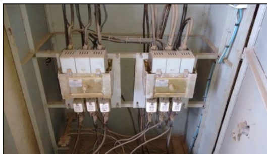
Figura 19 - Chaves elétricas do interior do painel (Acervo Pessoal).
