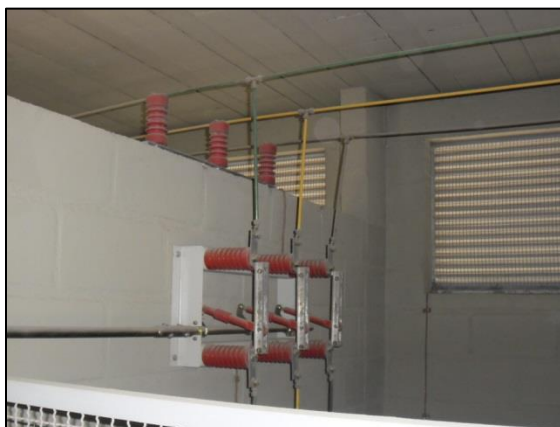
Figura 14 - Sistemas de entrada da Subestação Elétrica (Acervo Pessoal).
