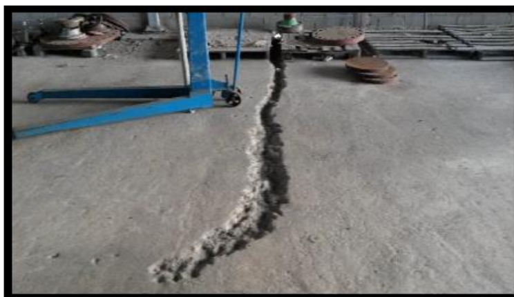
Figura 08 - Dreno improvisado para escoamento de efluente líquido de Teste Hidrostático (Acervo Pessoal).
