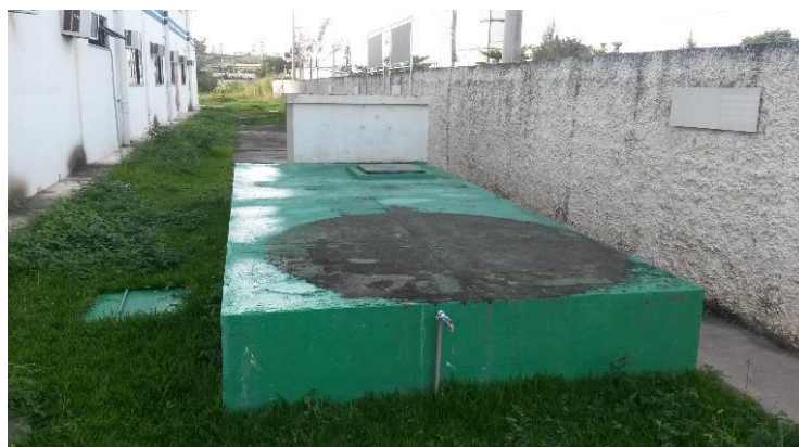
Figura 33 - Caixa subterrânea de 20 m³ próxima ao Prédio Administrativo (Acervo Pessoal).
