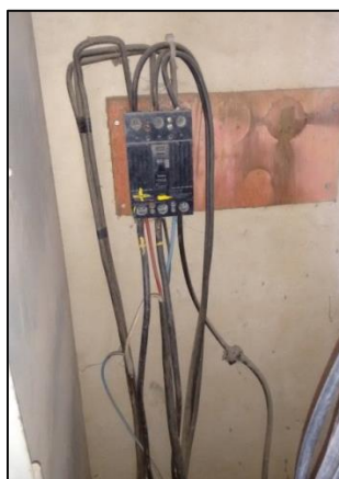
Figura 18 - Disjuntor fora do painel (Acervo Pessoal).
