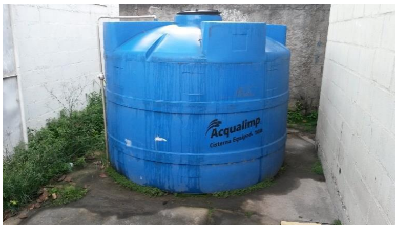
Figura 31 - Caixa d'água de 5 m 3 próximo a Subestação (Acervo Pessoal).
